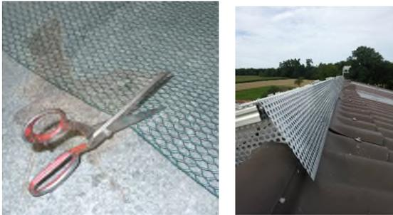
Oben: „Hasendraht“ zuschneiden und locker als Rolle zur Einfassung rund um die Module montieren oder die Module mit festem Lochblechgitter umfassen.
