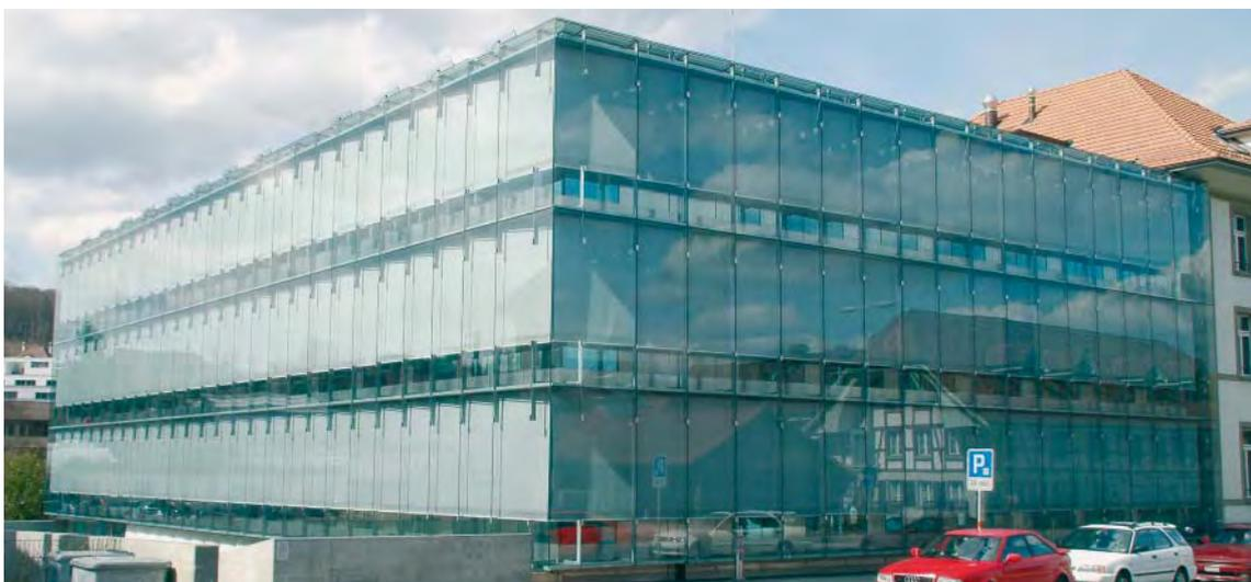
*In Glasfassade inwendig integriertes Beschattungssystem. Die Spiegelung ist zwar nicht völlig reduziert und sie wird durch den Aufnahmewinkel sogar noch etwas verstärkt. Trotzdem hält sie sich dank des hellen Stoffes einigermassen in Grenzen.*
