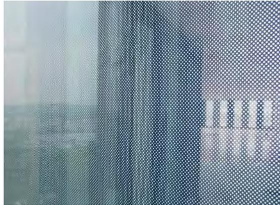
Feiner Punktraster. Dieser ist z.B. auch aussen an Bürogebäuden zur Reduktion von Spiegelungen einsetzbar.
