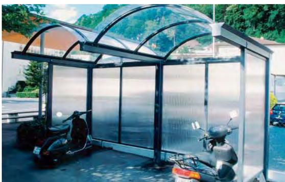
*Zweiradunterstand mit transluzenten Seitenwänden.*
