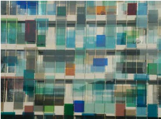
*Durch die Tiefenstaffelung und unterschiedliche Farbigkeit wird diese Fassade als Hindernis sichtbar.*
