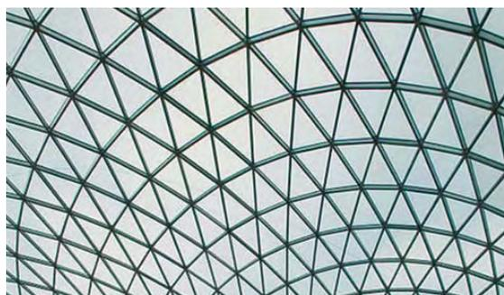
*Diese Dreieckskonstruktion ergibt eine noch verstärkte Netzwirkung.*
