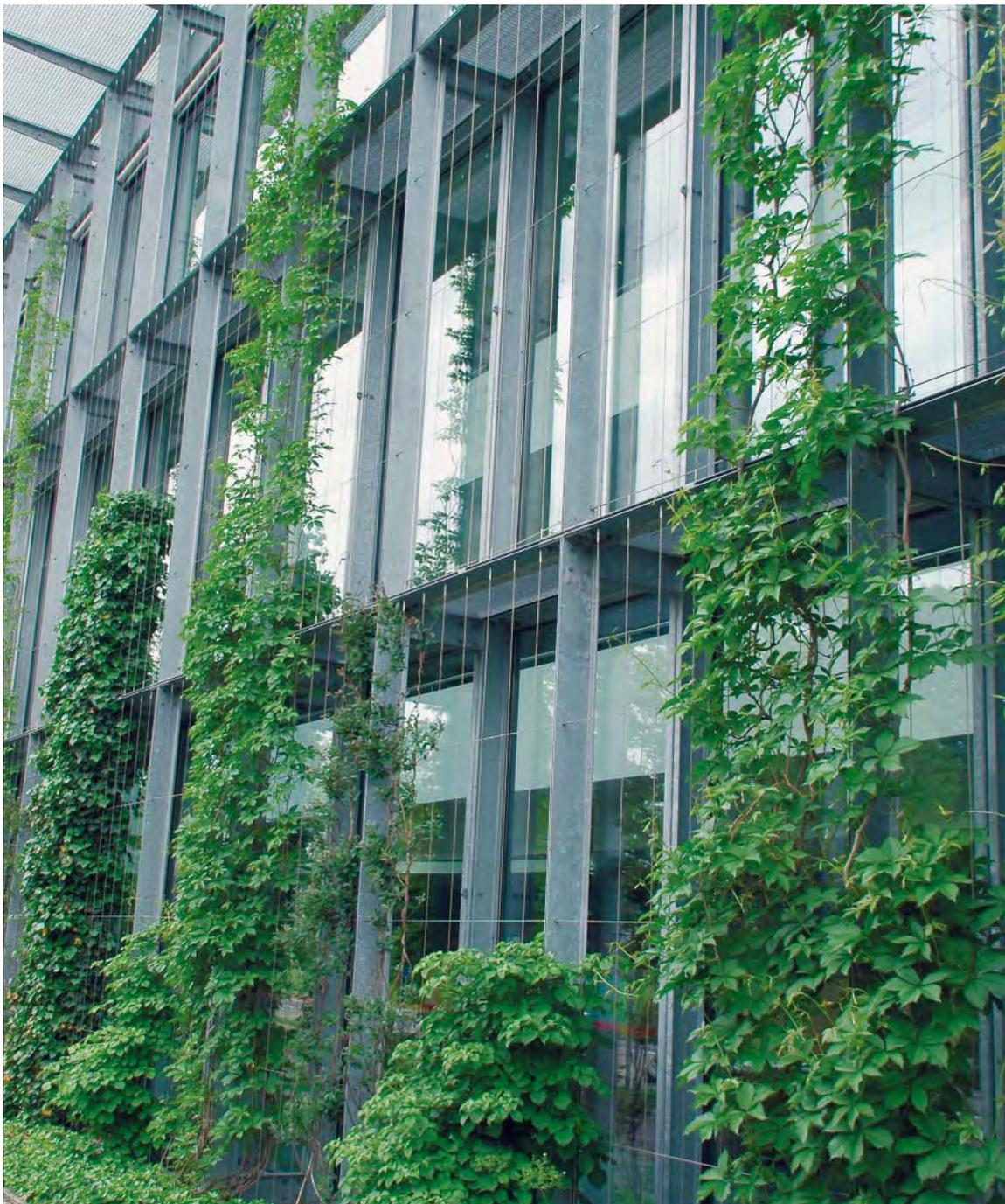
*Diese Fassadenbegrünung ist geglückt: Der Abstand zu den Scheiben ist gering, und das quer und hoch gespannte Rankgitter dürfte für Vögel gut sichtbar sein, so dass sich ein mehr oder weniger flächiger Schutz ergibt.*
