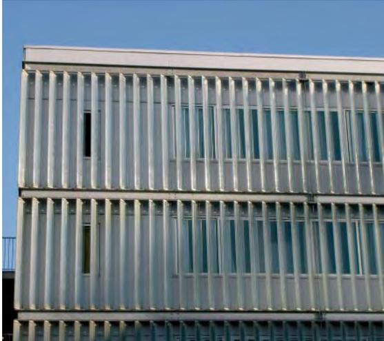
Vertikale oder horizontale Lamellen erzeugen einen Schattenwurf und gliedern die Fassade. So erkennen die Vögel die Fassade als Hindernis.
