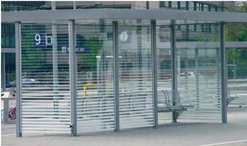
Wartehäuschen, kleine Lärmschutzwände, Windschutz-Verglasungen, Balkon-Brüstungen etc. lassen sich auch nachträglich gut mit horizontalen oder vertikalen Streifen ausrüsten. Dieses Objekt in München wurde von Beginn weg mit Siebdruckglas ausgerüstet.
