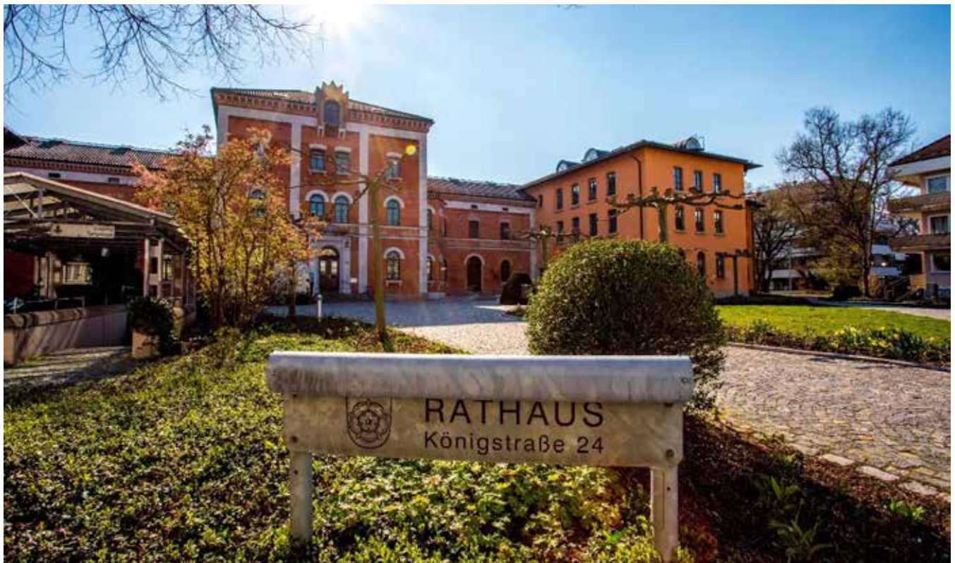
Abbildung 4: Das Rathaus der Stadt Rosenheim in der Vorderansicht. (Copyright: MH Photography)
